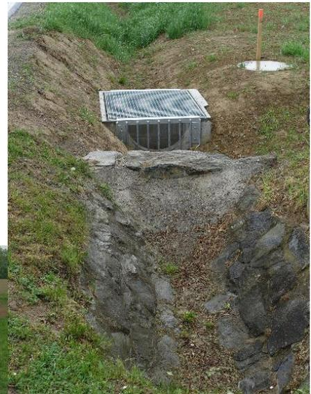
Einlaufbereich, der das Wasser unter der B57a zum Kanal überleitet
